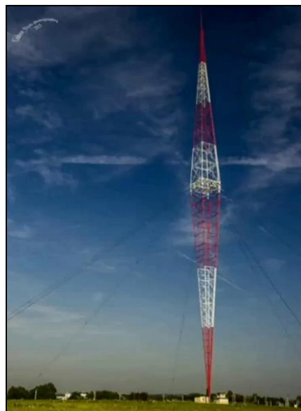
Anténní vysílací stožár BLAW KNOX v Liblicích u Českého Brodu, vysílací kmitočet 638 kHz, výkon 350 kW, Program Praha (v provozu 1937 – 1972).
