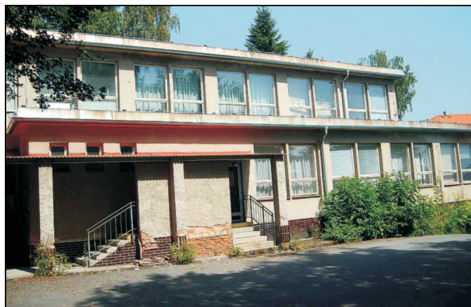
Stav budovy zvenku před rekonstrukcí
