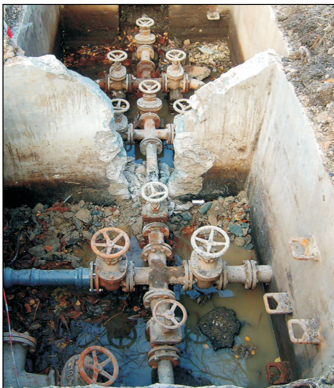
Stav obecního vodovodu před rekonstrukcí
