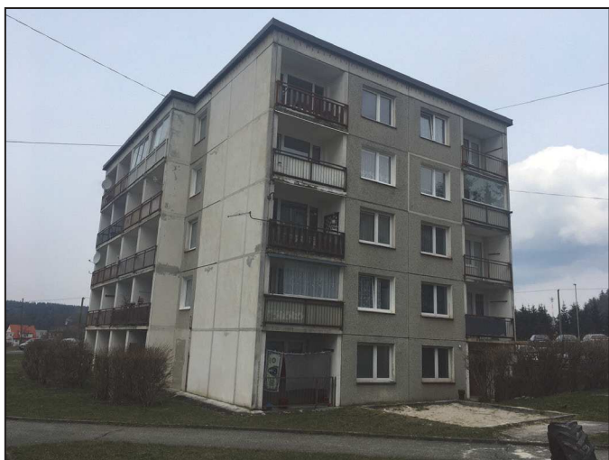
Bytovka č.p. 291 před rekonstrukcí
