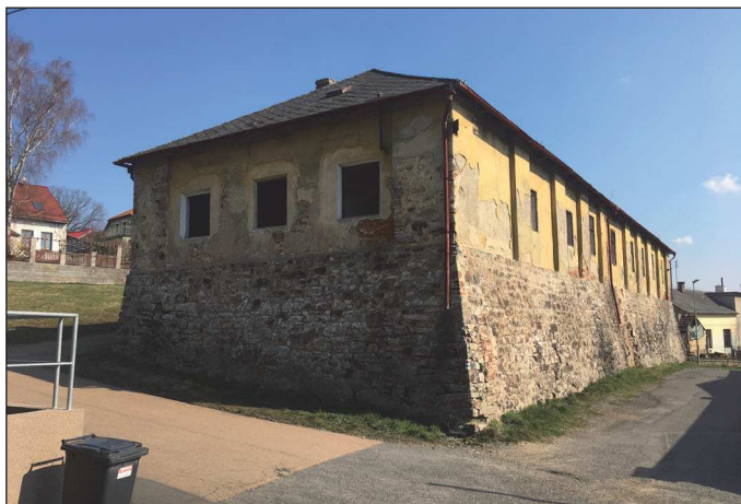
Dům č.p. 101 na Rudě před demolicí
