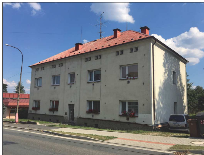
Bytovka č.p. 96 před rekonstrukcí
