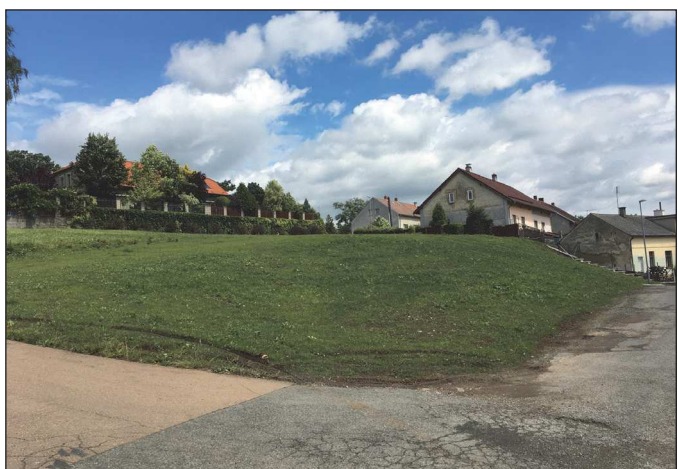
Prostor na Rudě po demolici
