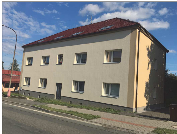
Bytovka č.p. 96 po rekonstrukci
