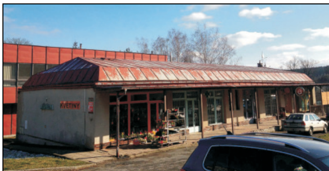
Dům služeb před opravou
