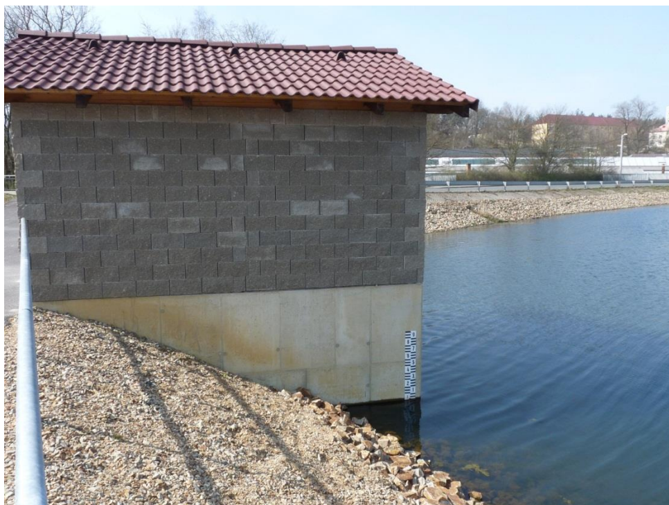
Obr. 2 Objekt spodní výpustě na hrázi Holoubkovského rybníka s vodočetnou latí.
