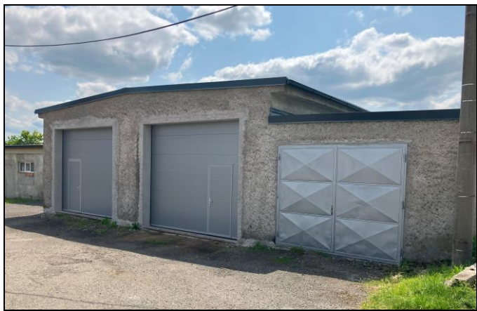
Pokračující rekonstrukce obecních garáží v Chejlavech
