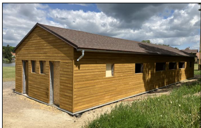
Přistavěná budova zázemí na hasičském cvičišti
