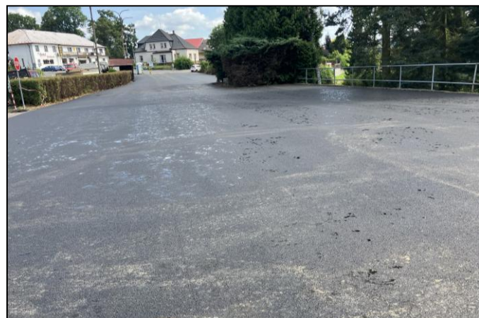
Stav parkoviště po vyasfaltování
