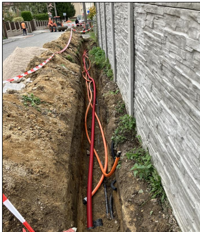
Do jednoho výkopu se pokládalo hned několik druhů vedení
