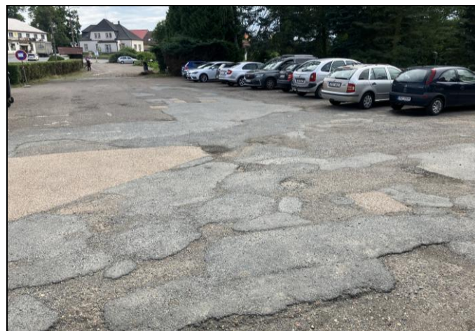
Stav parkoviště před vyasfaltováním
