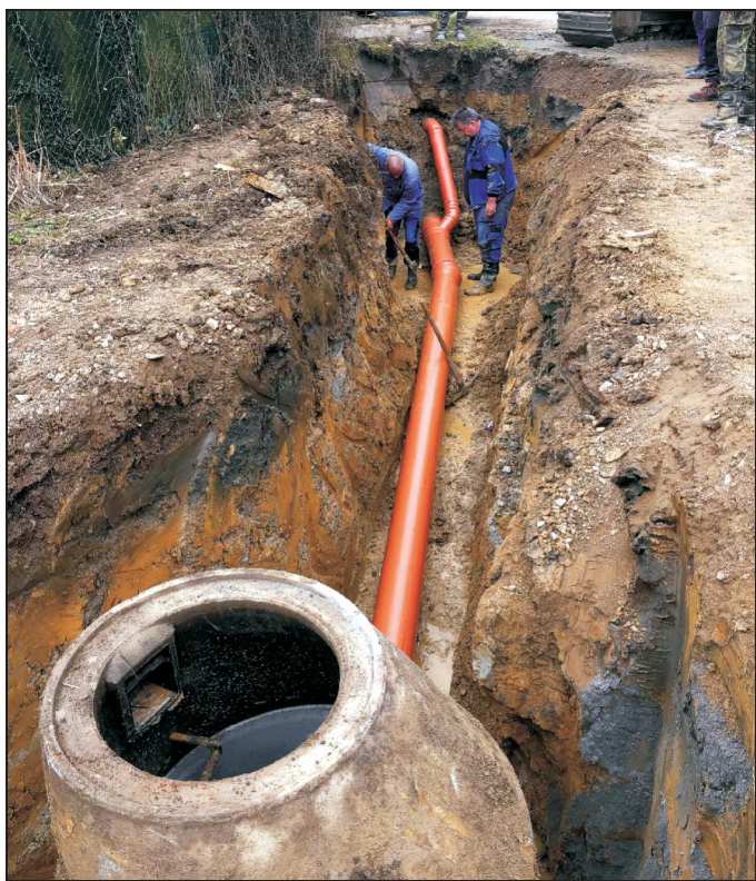
Pokládka inženýrských sítí v horní části Chejlav
