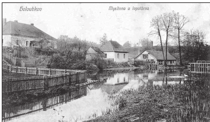
Oba snímky jsou před 1. světovou válkou. Na levém vidíme, jak se nádržka rybníček rozdvouje a levé rameno pohánělo kolo hamru Lopatárny. Přes potok šlo ještě jakési potrubí.
