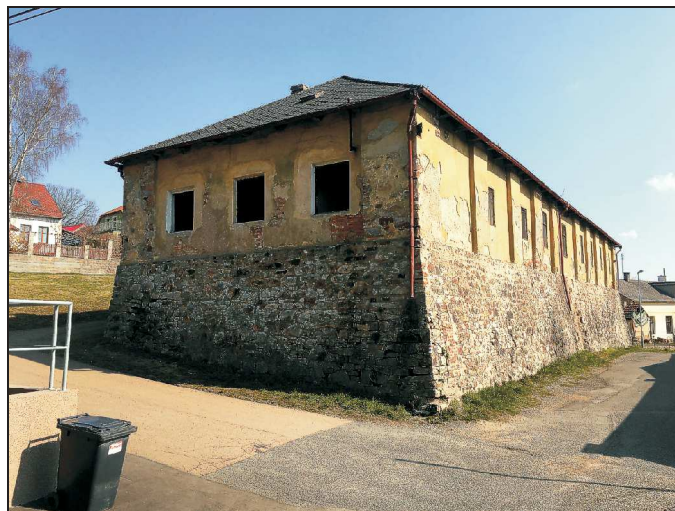
Prostor před demolicí
