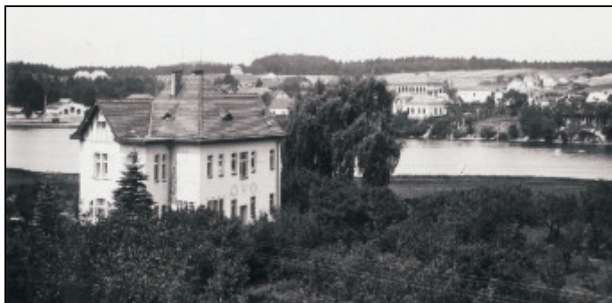
Na snímku z roku 1936 jsou už vidět domy na Těškovské, také na Okrouhlici vila Titlovic, postavená o rok dříve. Vlevo nahoře se nám objevily už i domy pánů Brože a Steinhausera. Mezi vrbou a střechou Chvojkovy vily vidíme dům Maříků (MUDr. Laštovky) zatím ještě v původní podobě.
